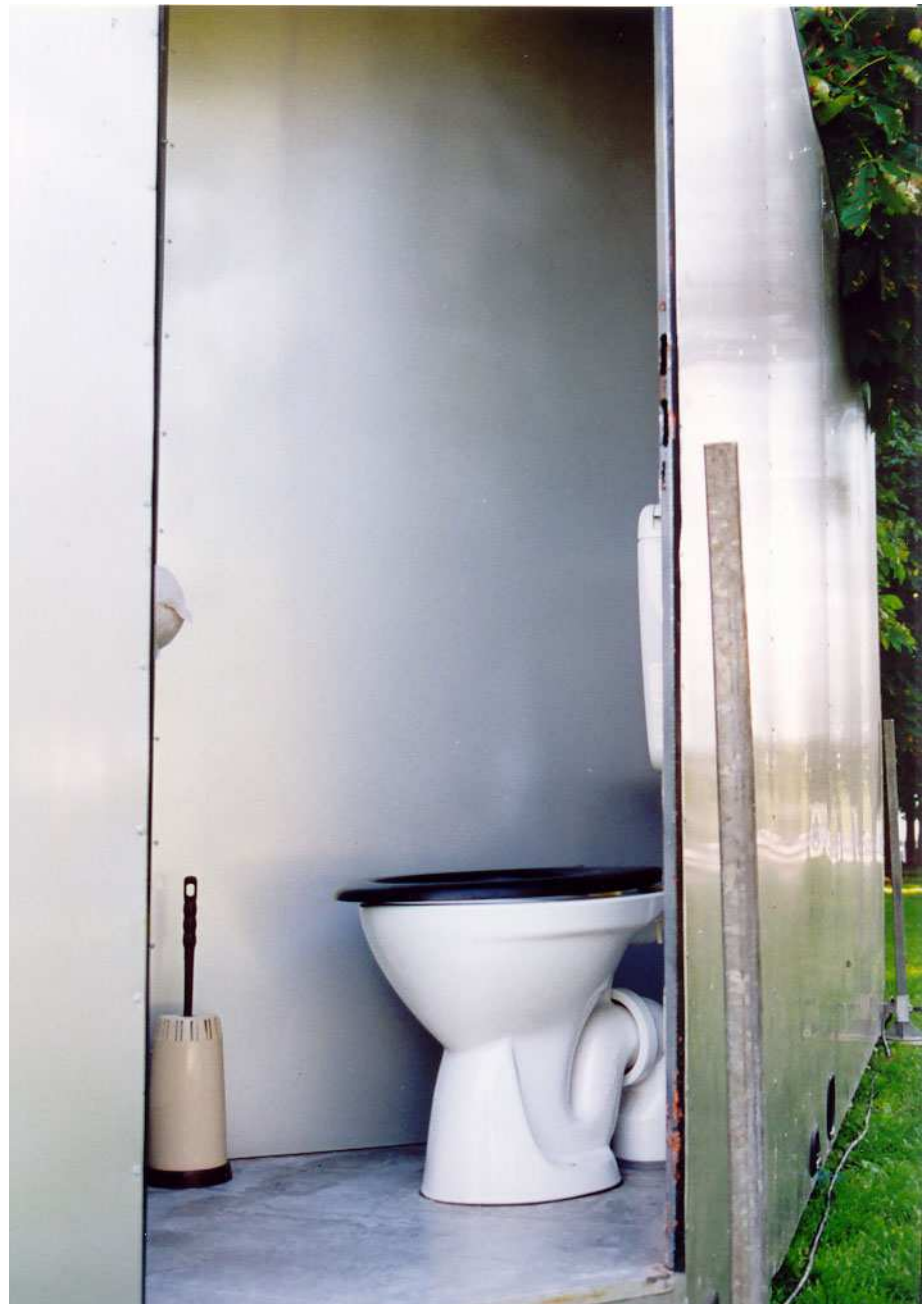
Ansicht: einzelne Toilettenkabine (Damen) Ansicht: Kabinenbereich (Herren)
